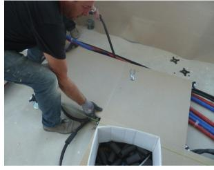
Dopo il montaggio il pavimento è ancora ispezionabile.
